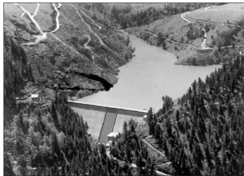
Bilbao no tuvo hasta 1933 un suministro adecuado de agua potable
